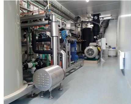
bezeichnet werden. Das Gerät besteht aus nichtmetallischen Komponenten, die hochmodular aufgebaut sind. Durch das einzigartige und patentierte 3D-Dampfrückgewinnungsverfahren ist das Design des DyVaR-Konzepts äußerst energieeffizient.
